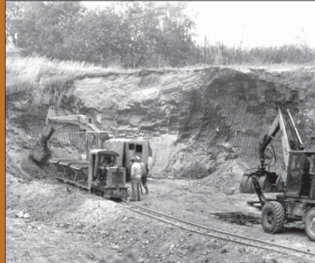
Tonabbau, um 1947 Transport erstmalig mit Feldbahnlok
