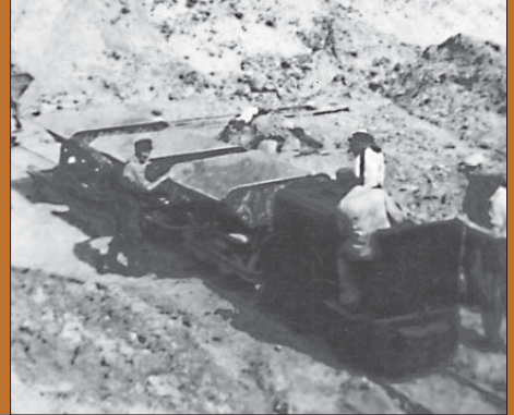
Tonabbau, um 1930 Beladung der Loren mit der Hand
