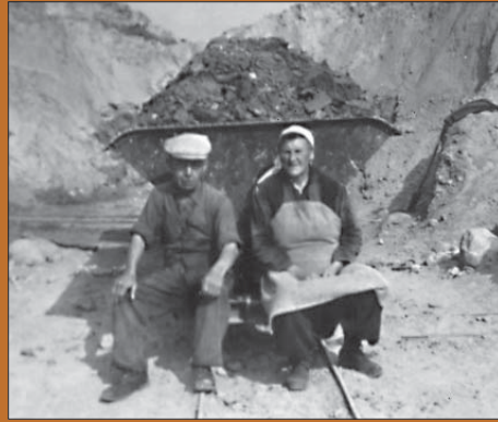
Tonabbau, um 1930 Beladung der Loren mit der Hand
